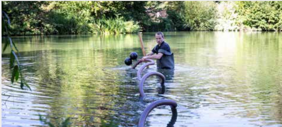
Installation eines Nano-Belüfters bei der Teichsanierung auf einem Gutshof in Niedersachsen. Die Luftblasen haben eine Größe von weniger als 76 nm und bleiben bis zu sechs Monate im Wasser.
