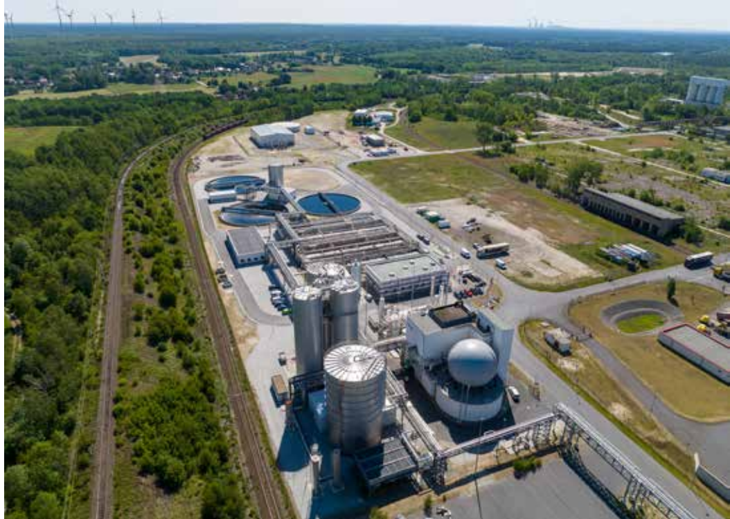
Die modernisierte Abwasserbehandlungsanlage II im Industriepark Schwarze Pumpe kann bis zu 8 Mio. m 3 Abwasser jährlich aufbereiten. Foto: ASG Spremberg GmbH
