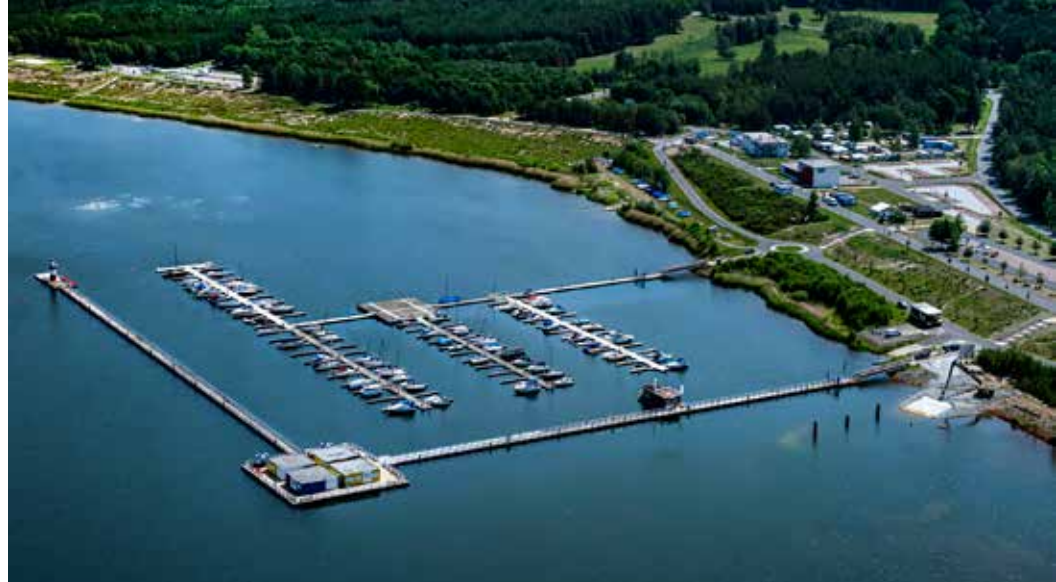
Der Bärwalder See gehört mit aktuell gut 12 Mio. m 3 Speichervolumen zu den größeren Speicherbecken in der Lausitz: Foto: LMBV, Peter Radke
