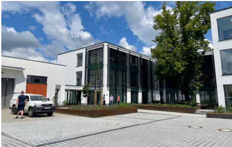
Der Neubau des Forschungsinstituts für Bergbaufolgelandschaften in Finsterwalde. © FIB
