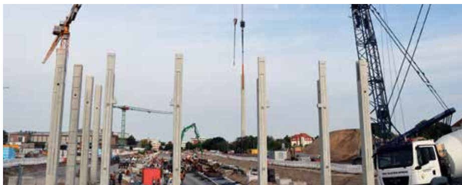
Auf Cottbus aktuell wohl größter Baustelle werden die Umrisse der zweigleisigen Halle für das neue Bahnwerk sichtbar. Foto: DB AG/ Frank Kniedstedt
