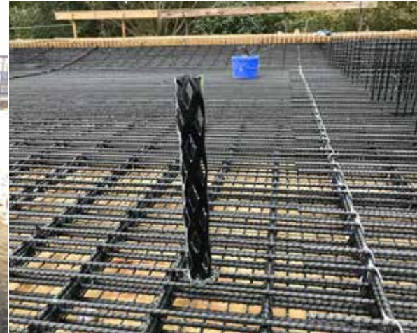
Die erste Carbonbeton-Brücke in Sachsen wurde in der Lausitz errichtet. In Wurschen bei Bautzen wurde die alte Brücke aus Stahlbeton vor zwei Jahren durch eine Brücke mit Carbonbewehrung (Detailfoto rechts) ersetzt – ebenfalls von Hentschke Bau. Die Firma fokussiert seit Jahren das Thema Leichtbau. © Hentschke Bau
