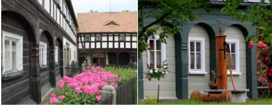
Typisch Oberlausitz: Beim Umgebindehaus trifft slawische Blockbauweise auf deutsche Fachwerkbautechnik. Foto: Stiftung Umgebindehaus
