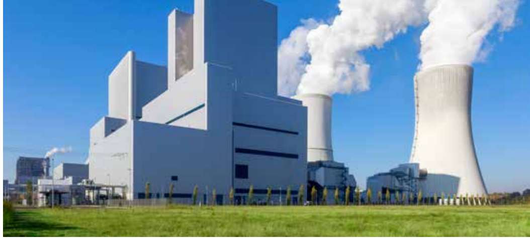
noch wird am Kraftwerksstandort Boxberg Energie aus Braunkohle gewonnen. Künftig will die LEAG hier grüne Energie für die Herstellung nachhaltiger Carbonfasern bereitstellen. Foto: Andreas Franke
