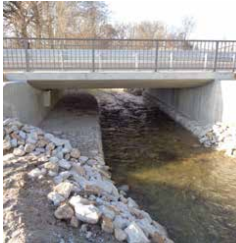
Die erste Carbonbeton-Brücke in Sachsen wurde in der Lausitz errichtet. In Wurschen bei Bautzen wurde die alte Brücke aus Stahlbeton vor zwei Jahren durch eine Brücke mit Carbonbewehrung (Detailfoto rechts) ersetzt – ebenfalls von Hentschke Bau. Die Firma fokussiert seit Jahren das Thema Leichtbau. © Hentschke Bau
