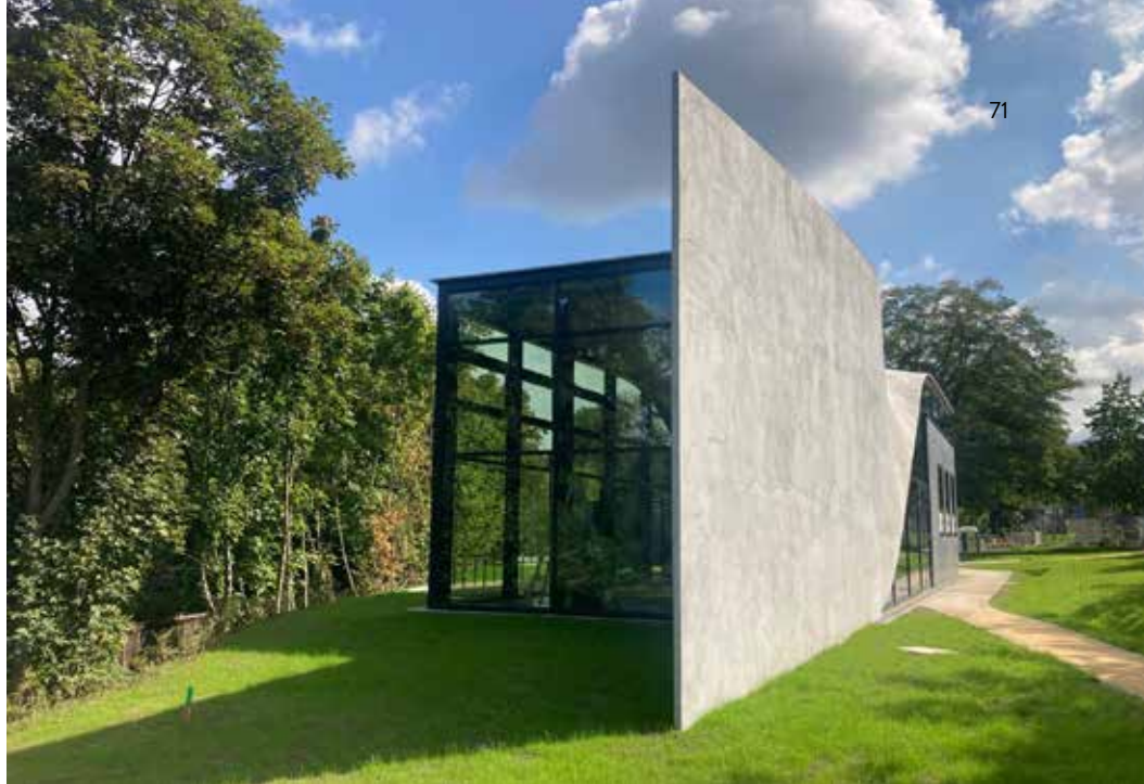
Der Cube in Dresden gilt als Leuchtturm-Projekt, er ist das weltweit erste Gebäude, welches vollständig aus carbonbewehrtem Beton errichtet wurde. Errichtet wurde es mit Lausitzer Kompetenz. Die Bautzener Firma Hentschke Bau hat das organisch geformte Bauteil „Twist“ errichtet. © Hentschke Bau
