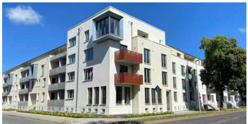
53 Wohneinheiten umfasst dieses Neubauensemble der eG Wohnen in der Cottbuser Amalien-/Ewald-Haase-Straße, das gerade im vergangenen Jahr fertiggestellt wurde.
