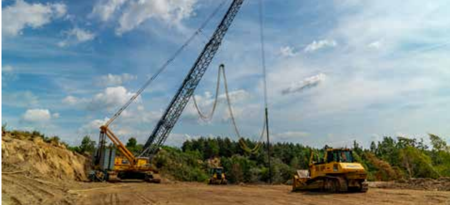
Die Bergbausanierung der LMBV ist nach 30 Jahren an vielen Tagebaufolgeseeen der Region nicht mehr so gut sichtbar wie am Restloch Greifenhain bei Altdöbern, wo derzeit die Rütteldruckverdichtungsstechnik instabile Böschungen sichert. Foto: Christian Horn
