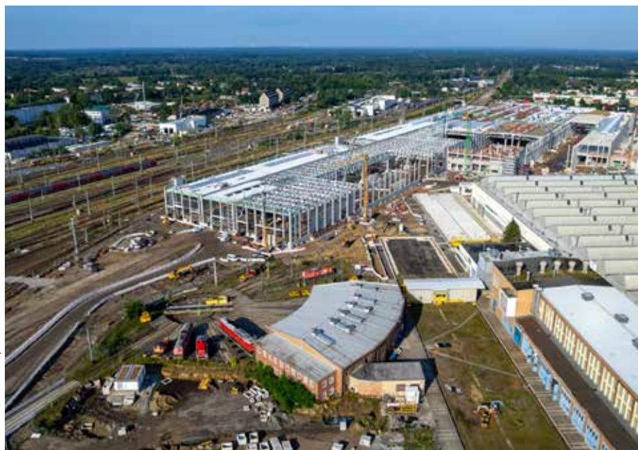
So sah der Blick auf die Baustelle für die größere Halle des Cottbuser Bahnwerks im Juli aus.
