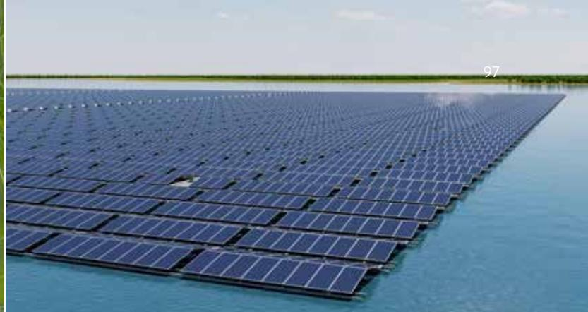
Die Visualisierung zeigt, dass die schwimmende Solaranlage mit 16 Hektar weniger als ein Prozent der gesamten Seefläche einnehmen wird und damit im Einklang mit den touristischen Nutzungszielen des Sees steht. Die rund 51.000 Solarmodule werden auf rund 1.800 Schwimmkörpern an 34 Dalben befestigt. © LEAG
