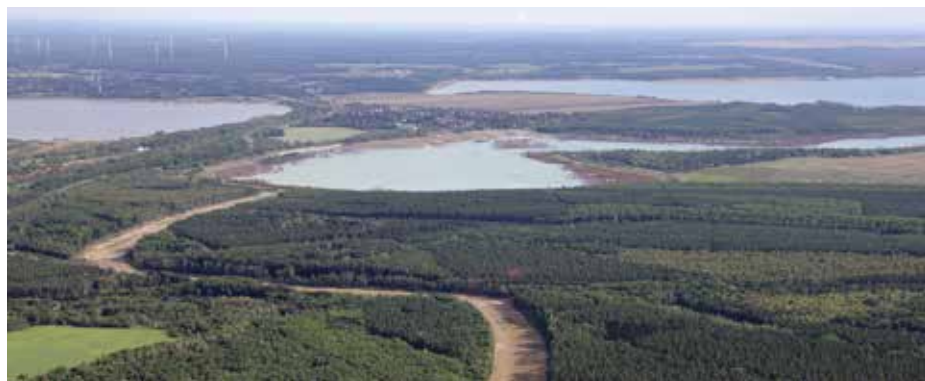
Die Luftaufnahme der Seenkette zeigt den im Bau befindlichen Ableiter des Sedlitzer Sees, eines der anstehenden Vorhaben der LMBV in der Lausitz. Foto: LMBV/ Steffen Rasche
