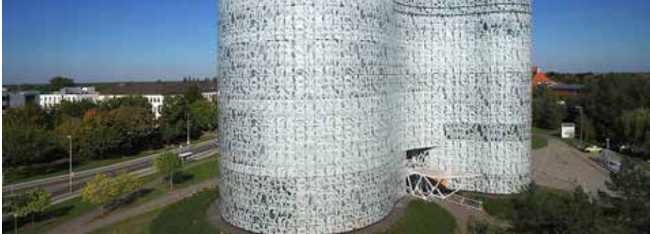
Das Informations-, Kommunikations- und Medienzentrum der BTU Cottbus-Senftenberg wurde vom Schweizer Architekturbüro Herzog & de Meuro gestaltet, das auch für die Elbphilharmonie Hamburg verantwortlich zeichnete. (Foto © BTU Cottbus-Senftenberg)
