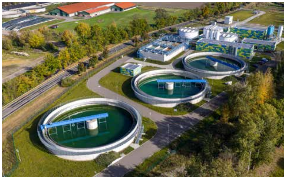
Gebaut auf lange Sicht: Die Wasserbehandlungsanlage bei Plessa reinigt seit Oktober 2025 im dreimonatigen Probetrieb eisenhaltige Wässer und schützt so die Schwarze Elster vor Eisenhydroxidschlamm und Verockerung. Der Einfahrbetrieb wird ein weiteres Jahr dauern, bis die Anlage in den Regelbetrieb übergehen kann. Foto: LMBV/Christian Horn
